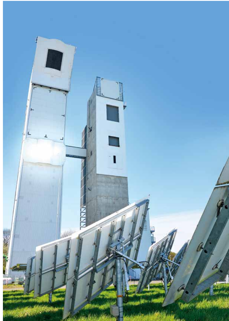
Impressionen aus der Demonstrationsanlage von Synhelion in Jülich: Spiegel reflektieren die Sonneneinstrahlung und bündeln diese in einem Solarturm (grosses Bild). Ein Solarreceiver (Bild oben links) generiert dort die für die Herstellung erneuerbarer Treibstoffe notwendige Prozesswärme. Das Team um CEO Philipp Furler (ganz links im Bild) will mit dieser Technologie einen signifikanten Beitrag zur Energiewende leisten.
